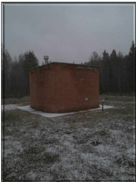
Помещение скважины. Вид снаружи
