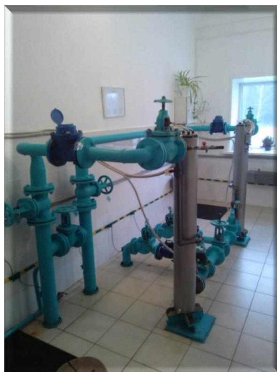
Установка обеззараживания
